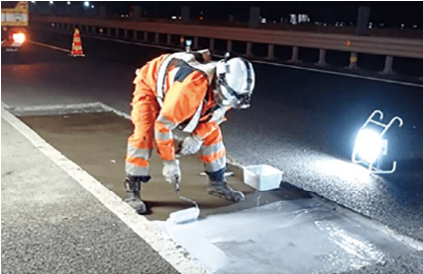
防水材の塗付
