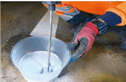
防水材の攪拌
