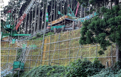
マルチ GRID YELLOW：急斜地工事（北海道）
