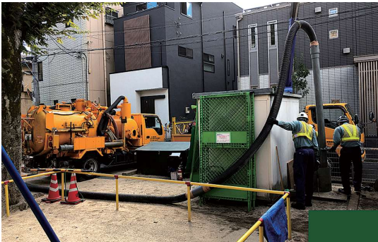
狭陰箇所での掘削作業
