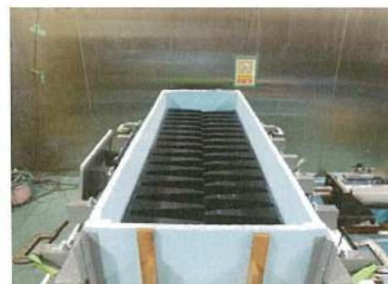
水張枠作製完了 (側面)
