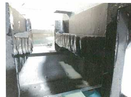
接着剤・シーリング材塗布
