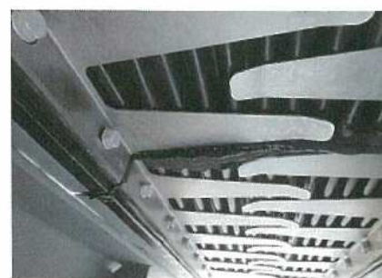
終了時簡易水張り 下面 (漏水なし)
