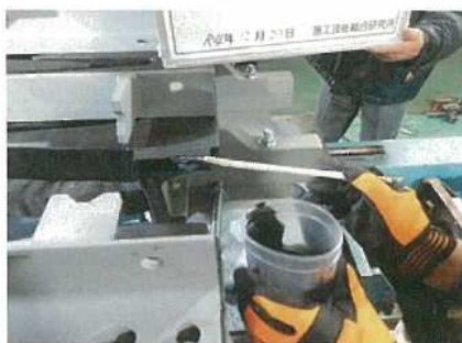
接着剤・シーリング材塗布
