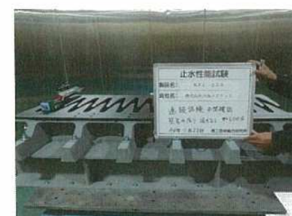
中間簡易水張り 側面（漏水なし）
