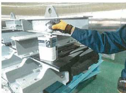
接着剤・シーリング材攪拌
