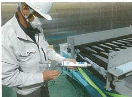
水張枠作製状況 (1)
