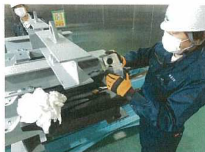
接着剤・シーリング材塗布準備
