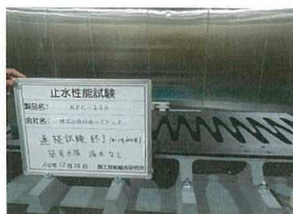
終了時簡易水張り 正面 (漏水なし)
