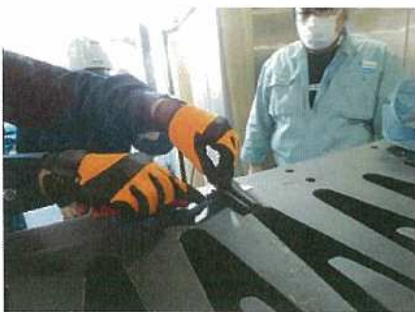
余剰止水材の切断処理
