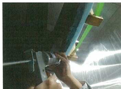
水張枠作製状況 (2)
