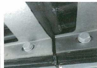
水張り試験終了（漏水なし）
