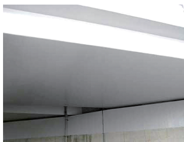
ナイロン繊維シート(特殊加工)/エポキシポリマーセメントによるコンクリート片剥落防止対策システム
