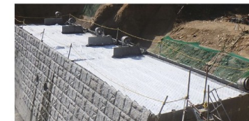
コンクリート表面に十分散水し、キュアライトを敷設する
