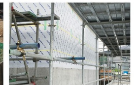
垂直面への施工事例
