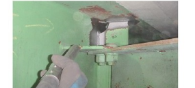
ショットピーニング 施工状況
