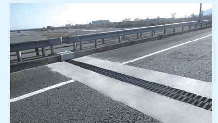
東名高速道路 安倍川橋
