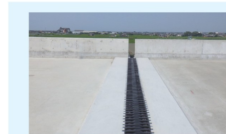
有明海沿岸道路 大川高架橋
